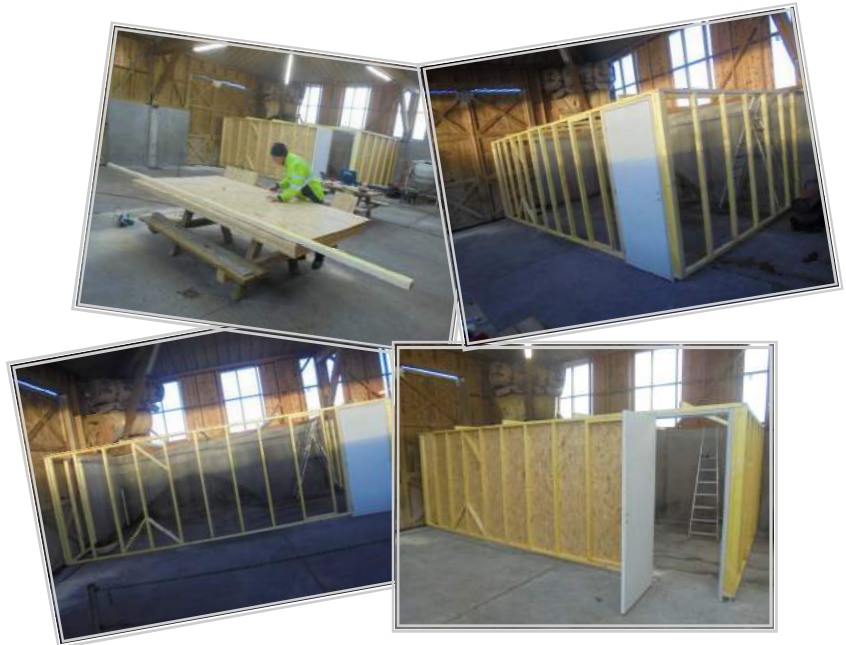
Local de pétanque en construction
