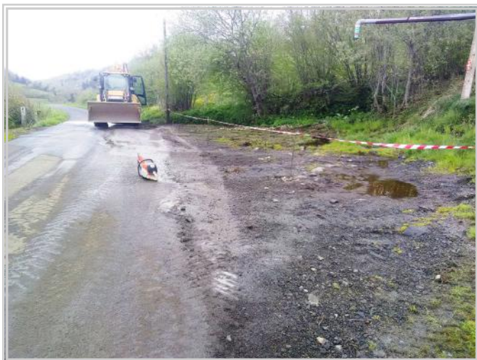
⇐ Chute d'eau à Limagne
