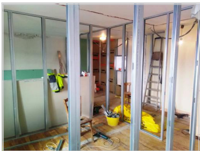
⇐ Travaux gîte Laniac
