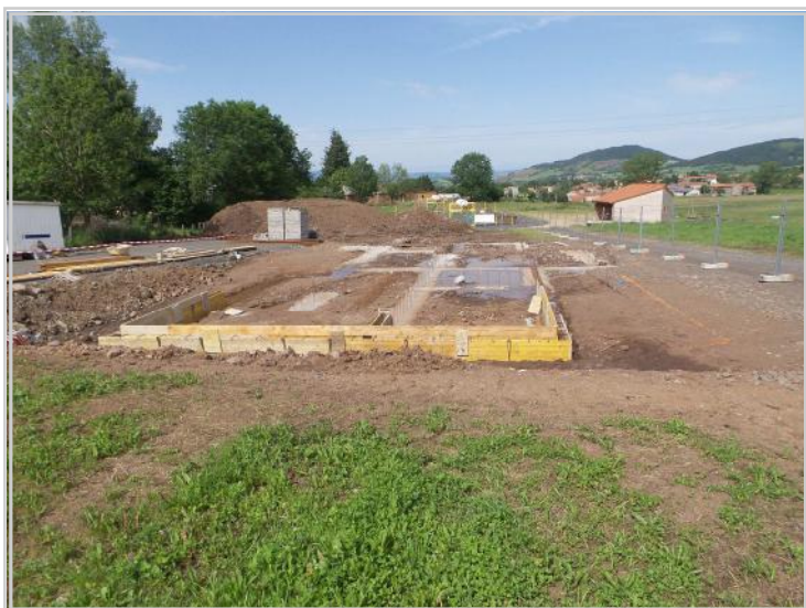
⇐ Travaux terrassement gros œuvre : GAILLARD Construction
